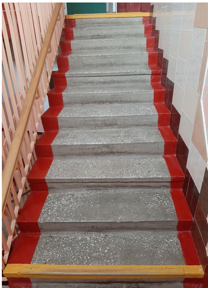
Контрастная маркировка с тактильной накладкой верхней и нижней ступеней лестниц
